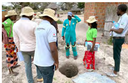
養成したファシリテーターが 家庭用トイレの建設進捗を確認する様子
