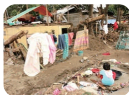
【倒壊した民家】
